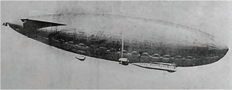
شكل ١-٧: المنطاد الشبه المتماusk ن. ١ N. ١، أحدث ما بنته إيطاليا من هذا النوع.
