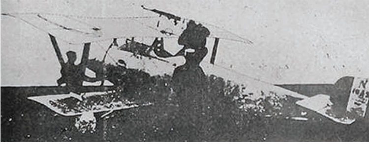
شكل ١١-٢: محاربة فرنسية خفيفة من طراز نيو بور، على جناحها العلوي مدفع يُطلقه الطيار بواسطة سلك يصله إلى منزله.
